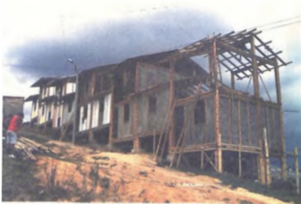
Imagen 1. Construcción Urbanización La Divina Providencia. Tomado de: Construcción y Dirección de la “Urbanización la Divina Providencia” del Arquitecto Gilberto Florez.
