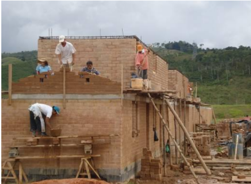
Imagen 4 Proceso de construcción Urbanización Casa Viva. Tomado de: Proyecto piloto de Vivienda de Interés Social en bloque de tierra de Fundación para la Preservación, la Innovación y el Desarrollo de la Arquitectura en tierra (Fundación tierra viva).
