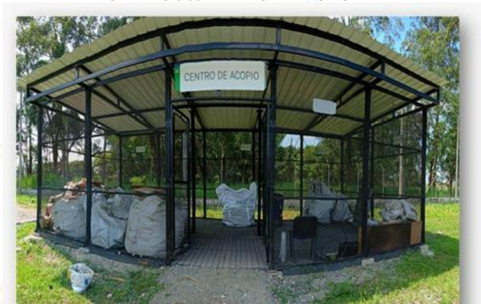
GRAFICO 3.38. CENTRO DE ACOPIO ZFC
