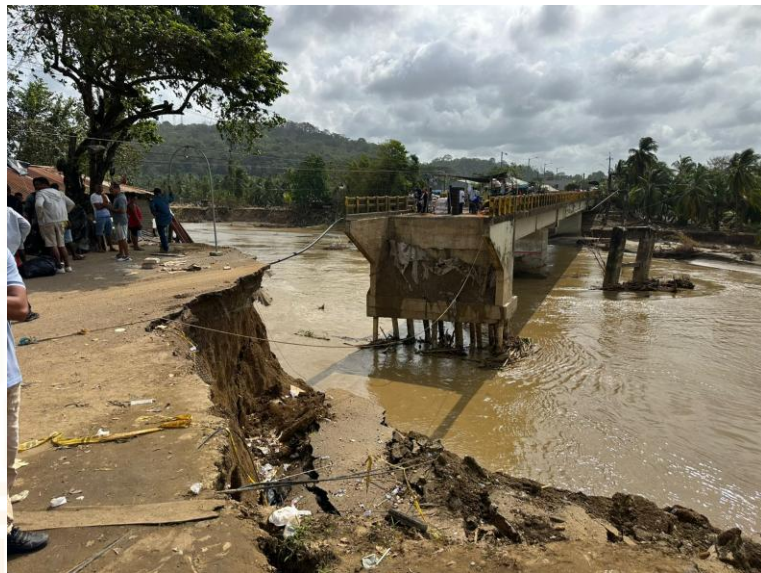
Puente Vía Nacional sobre el Río San Jorge
