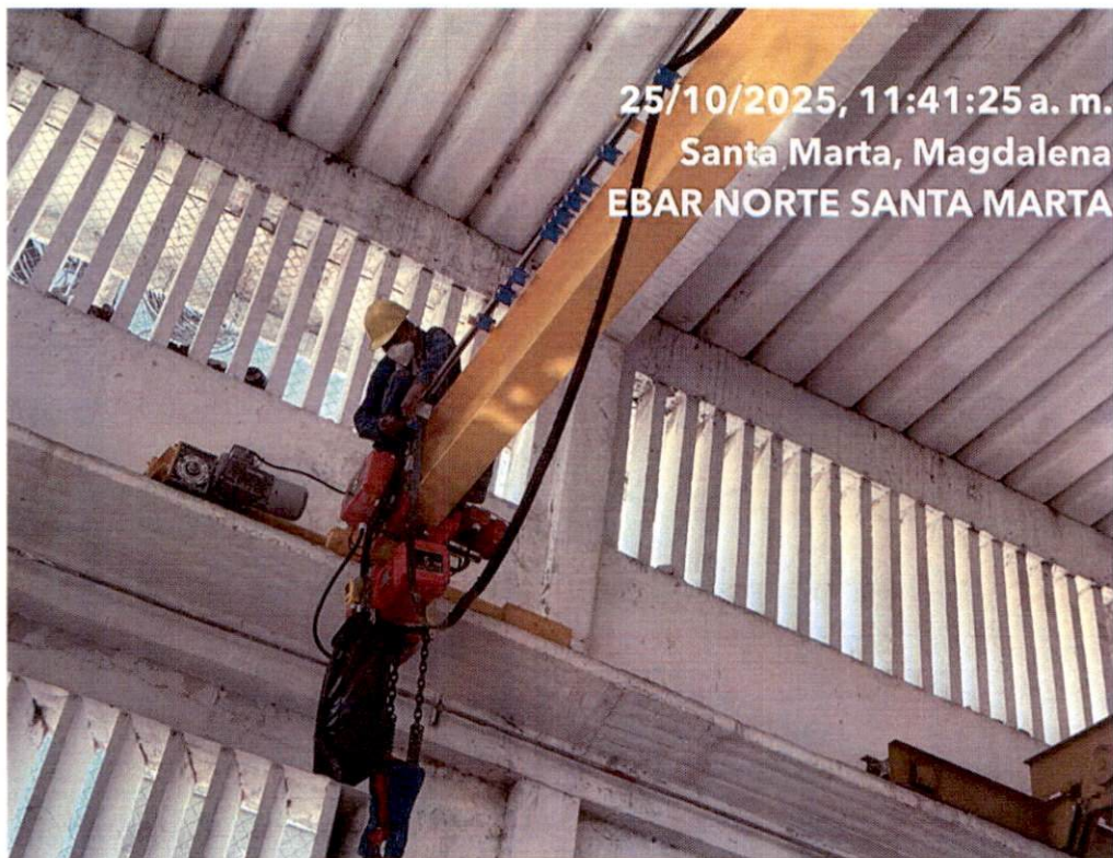
Figura 5. Instalación nuevo Puente Grúa EBAR NORTE.
