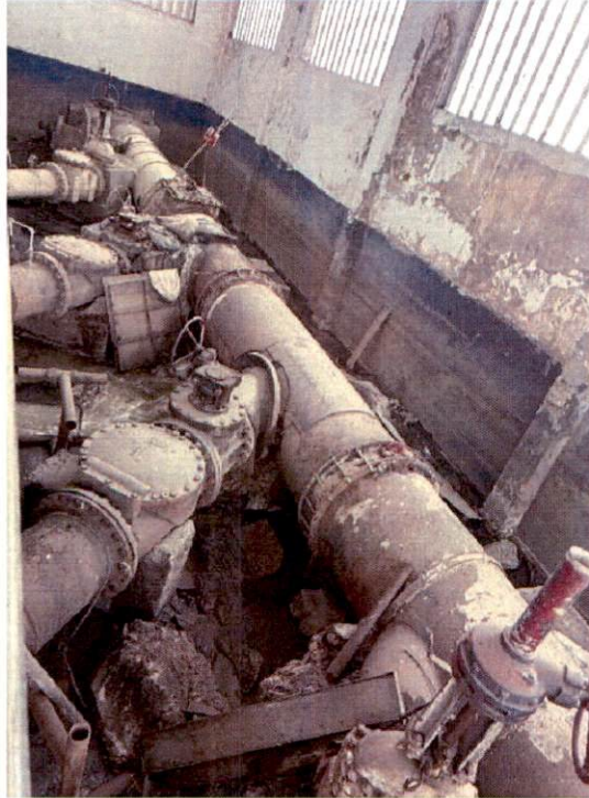
Figura 3. Estado inicial Múltiple.
