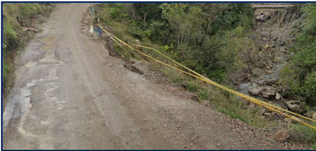
Tramo en donde se encuentra socavado el talud inferior de la plataforma de vía.
