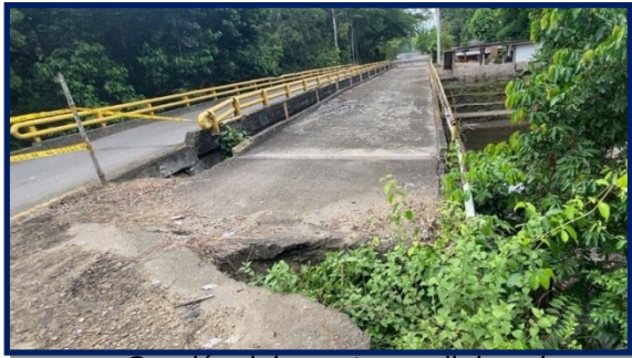
Sección del puente, carril derecho, fallado por socavación de estribo derecho.
