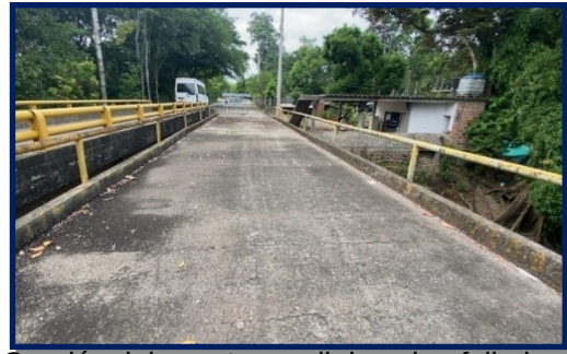
Sección del puente, carril derecho, fallado por socavación de estribo derecho.
