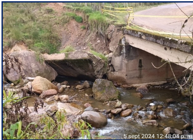
Muro fallado, estribo derecho, aguas arriba quebrada honda.
