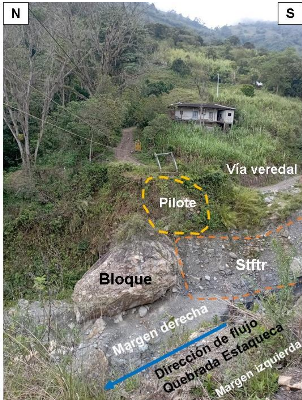
Figura 10. Imagen del 2 de abril de 2025 de la margen derecha de la quebrada Estaqueca en donde aún se ubica un pilote del puente peatonal que fue derribado por recurrentes flujos torrenciales. Suelos transportados fluviotorrenciales recientes - Stftr.
