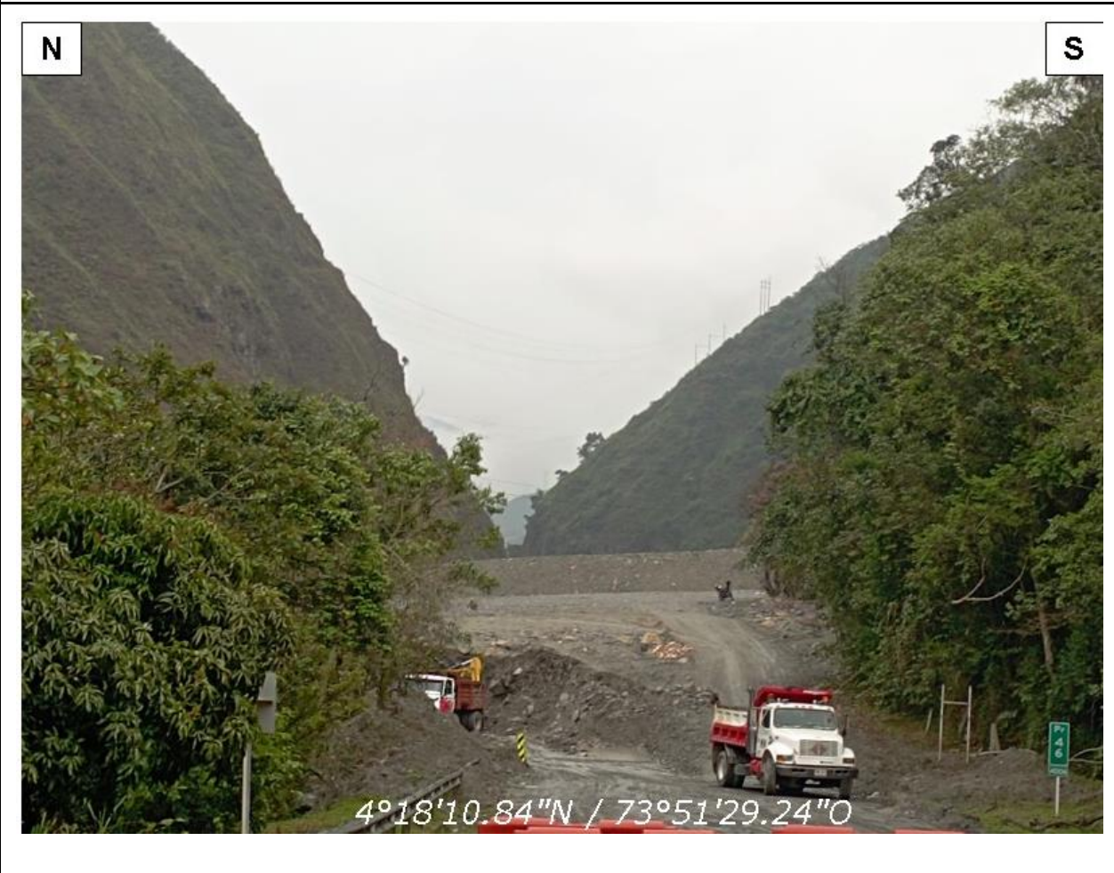
Figura 20. Fotografía del 2 de abril 2025, depósito fluviotorrencial el cual presenta una estructura masiva de detritos de la quebrada Estaqueca en su desembocadura en el rio Negro y sobre la vía Bogotá – Villavicencio.
