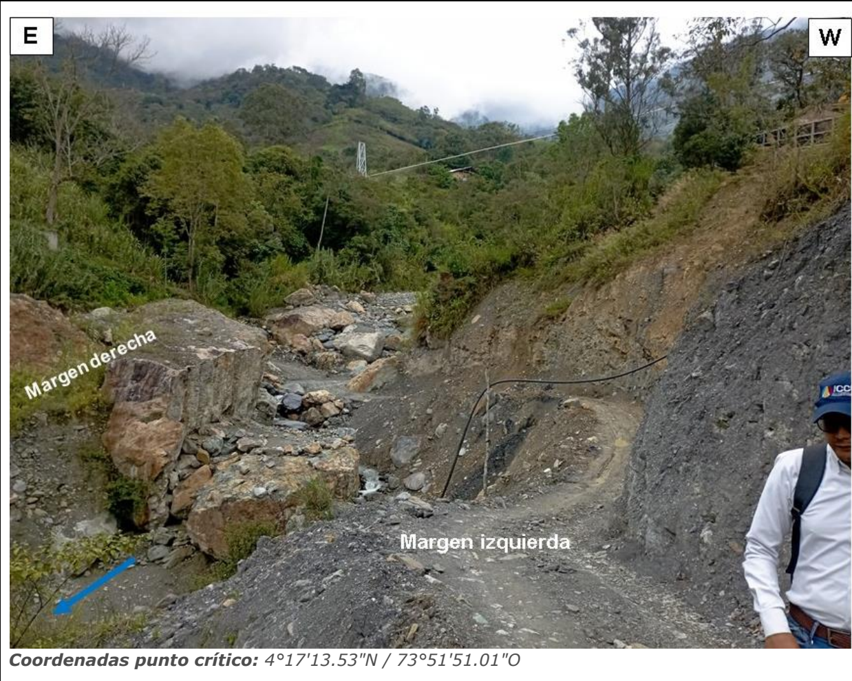
Figura 11. Fotografía del 2 de abril de 2025 desde la margen izquierda de la quebrada Estaqueca. Se observan bloques de aproximadamente 4 m de diámetro que han sido transportados por los flujos torrenciales. La vía se encuentra trazada sobre depósitos coluviales y aluviales anteriores. Se puede evidenciar la socavación continua de los márgenes de la quebrada.
