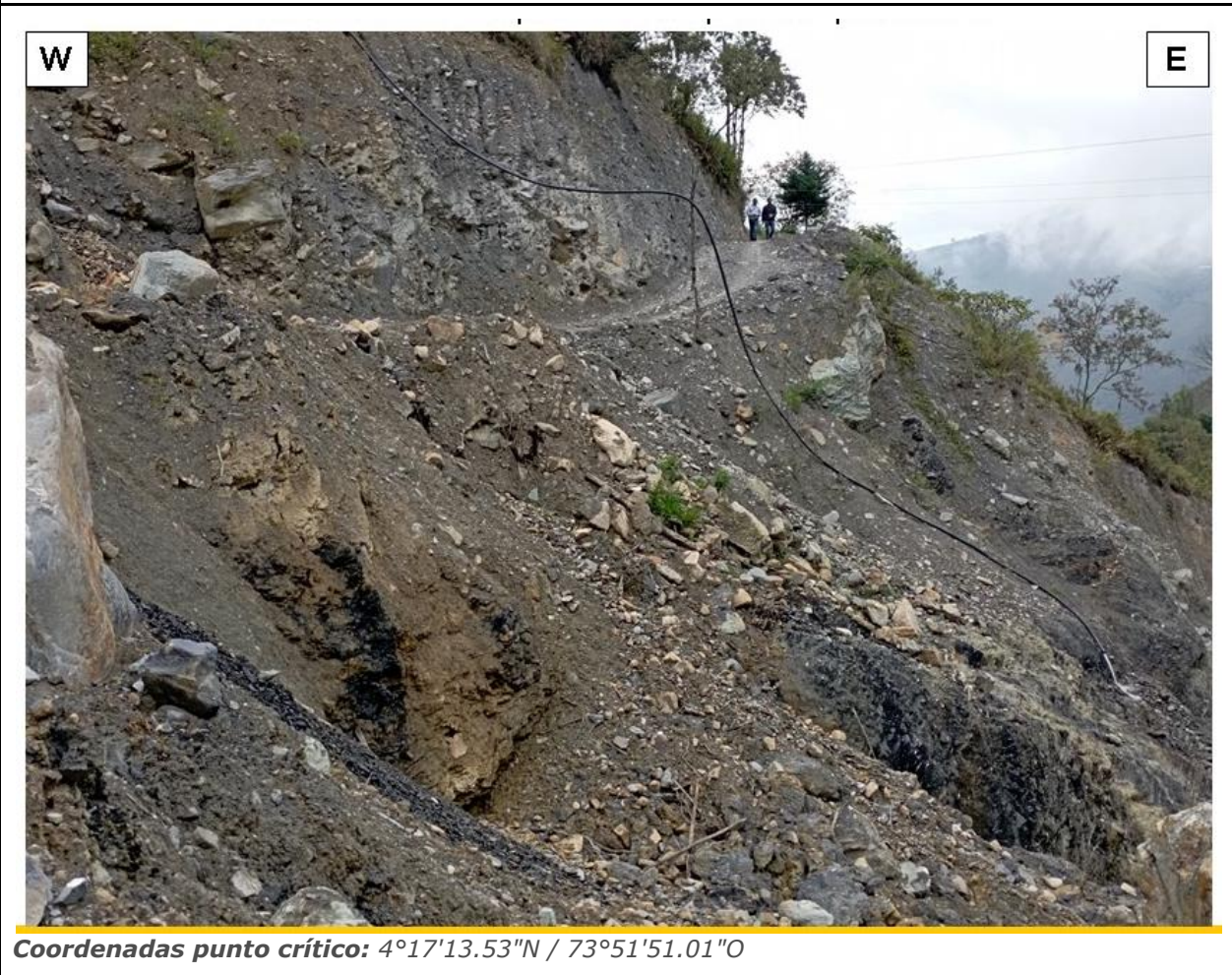
Figura 13. Fotografía del 2 de abril 2025 de la margen izquierda de la quebrada Estaqueca donde se ubicaba la cimentación izquierda del puente peatonal. Se observan en las imágenes los distintos tipos de litologías (principalmente filitas, cuarcitas y pizarras del grupo Quetame y arcillolitas, limolitas negras con arenitas de la formación Macanal) asociadas a las márgenes de la quebrada y al aluvión en el lecho de la quebrada.
