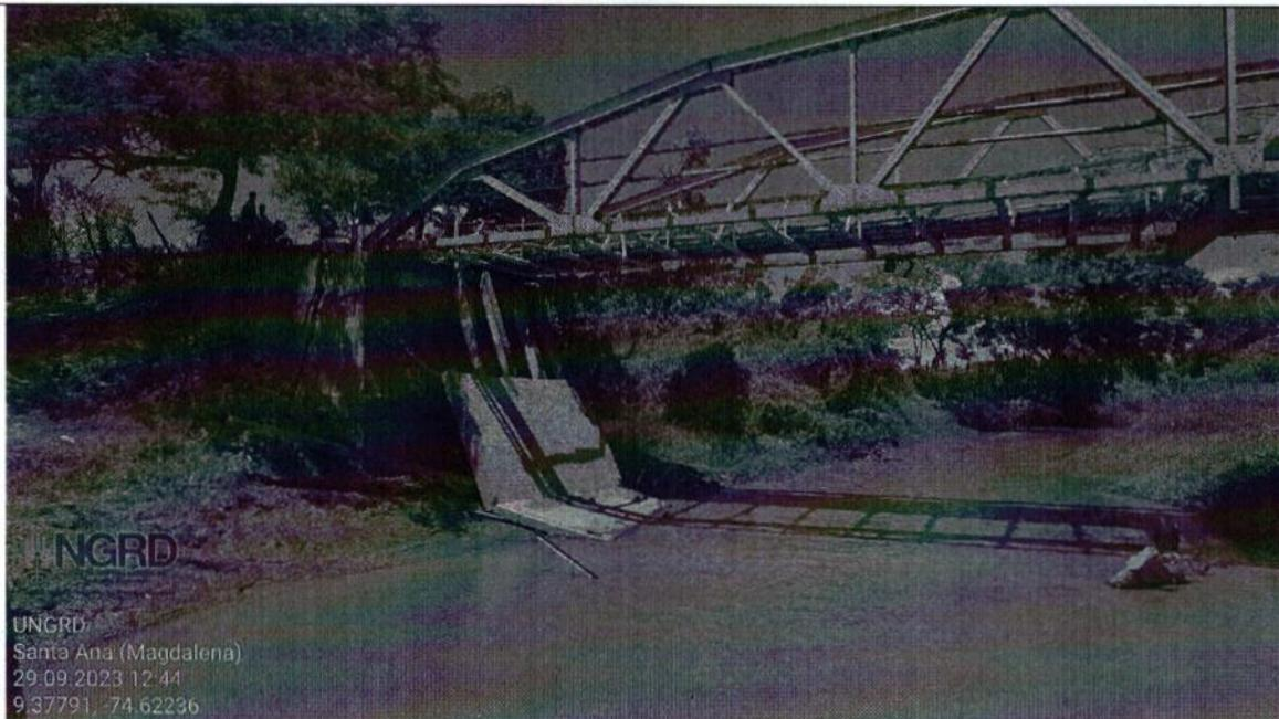
Después de la visita se da cuenta que la estructura que soporto el puente metálico por muchos años ya no está en capacidad de hacerlo, por lo tanto, la primera tarea que se debe desarrollar es la demolición de las estructuras existentes para construir las obras necesarias para instalar el puente metálico modular y darle seguridad a la estructura.
