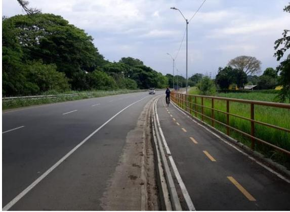
Fotografía No. 05. Se observa barandas de protección, sobre muros en tierra armada de la ciclovía.
