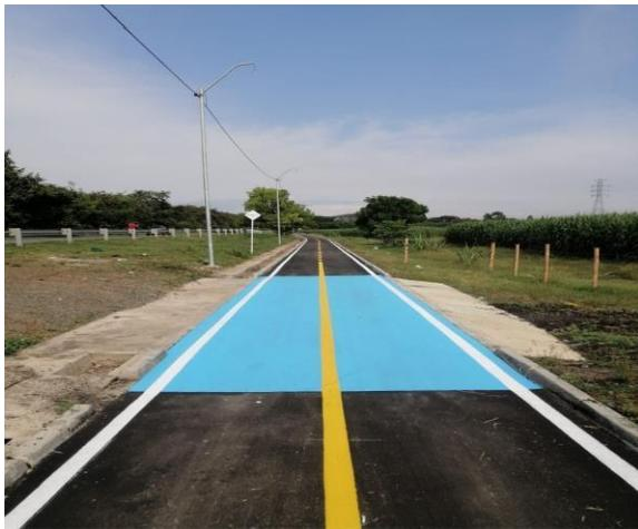
Fotografía No. 11. Se observa la señalización de la ciclovía.
