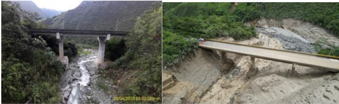
Ilustración 3. Antes y después del Puente Naranjal – Bogotá – Villavicencio (K50+225)
