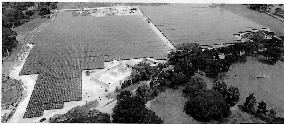
Ilustración 10 Subestación Helios 34.5 KV.
