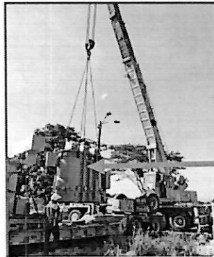
Descargue de transformador de 10 MVA N° SERIE: 142859-1309 en la subestación Apiay
