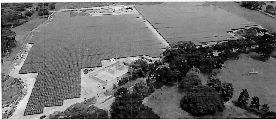
Ilustración 10 Subestación Helios 34.5 KV.
