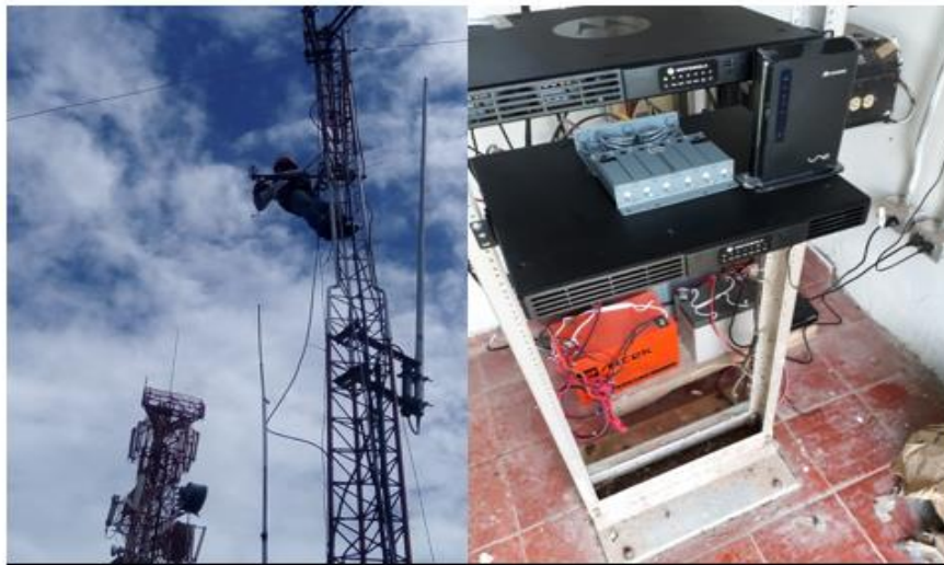
Traslado y puesta en funcionamiento de equipo repetidor en el municipio de VALDIVIA.
