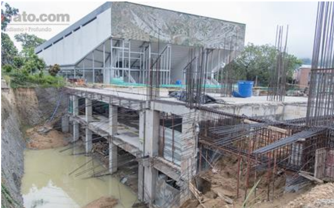
Fuente: Diario elofato.com (2016). Carrera Quinta en alto riesgo por gigantesco hueco de la Unidad Deportiva de la 42. Recuperado de http://www.elofato.com/carrera-quinta-en-alto-riesgo-por-gigantesco-hueco-de-la-unidad-deportiva-de-la-42/
