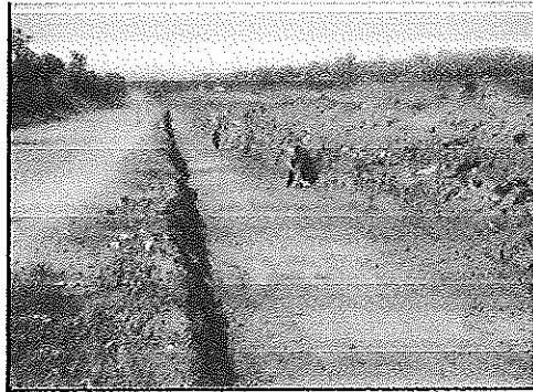
FOTO 4 LIMPIEZA DEL CAJEO MARGEN IZQUIERDO
