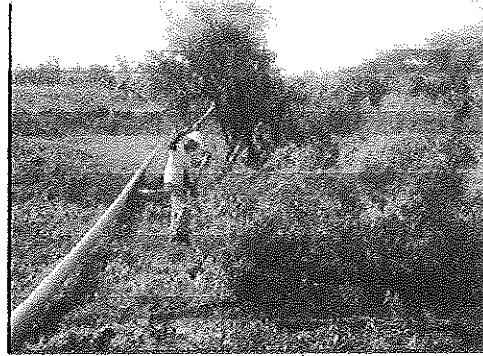
FOTO 2 TRASLADO DE TUBERIA A LOS PREDIOS
