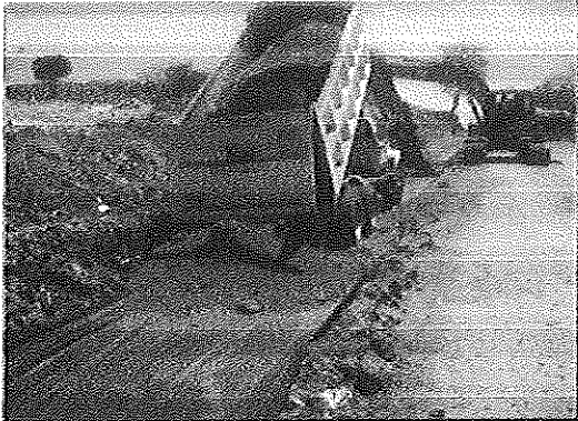
FOTO 7 EXTENDIDA DE MATERIAL EN EL CAJEO
