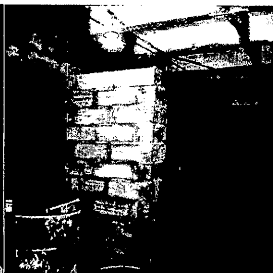
Mampostería baños patio 4 segundo piso.
