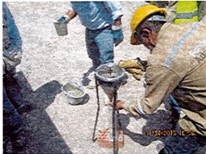
Ensayo fluidez en inyección ducteria anclajes viga riostra inferior, Pila 3.
