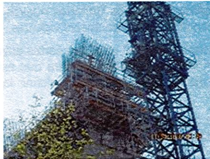
Posicionamiento de aceros trepa 7, Pilono 4, h : 35,87 mts.- Hisgaura
