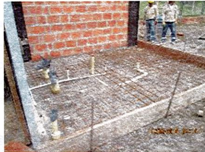
Construcción placa cimentación escuela Labranza Grande.
