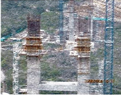
Construcción trepas 11 de la Pila 3.
