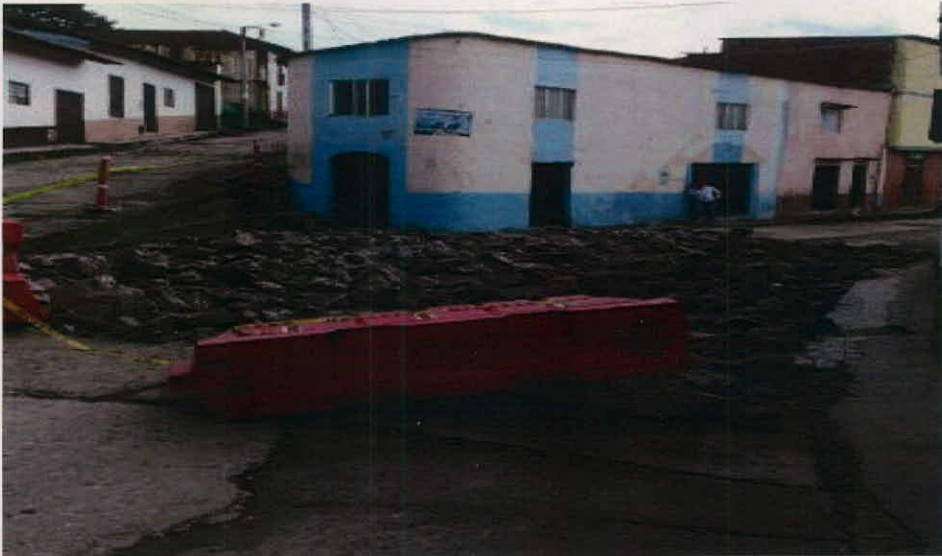
ASPECTO DE LA DEMOLICIÓN DEL PAVIMENTO EN GUCA
