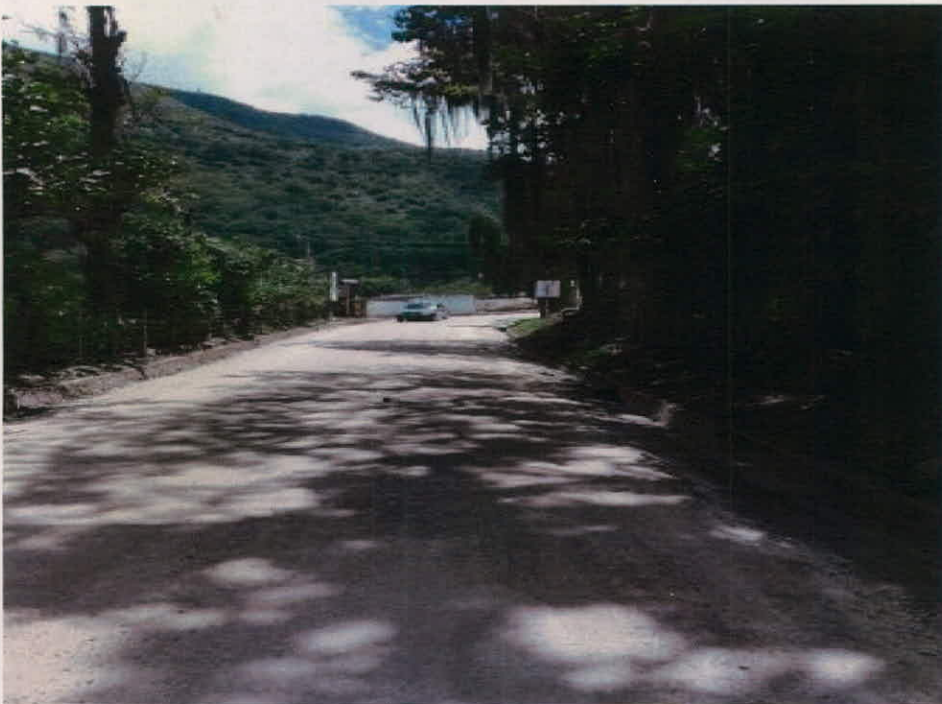
VISTA DEL MANTENIMIENTO 49+250
