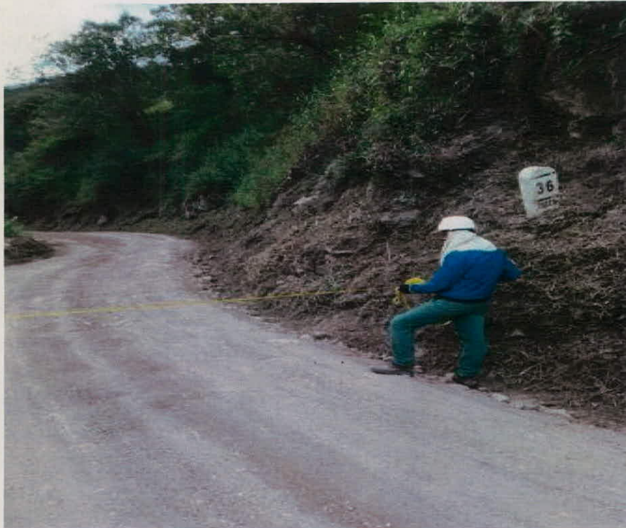
CONFORMACIÓN DE LA VÍA PR 36+000
