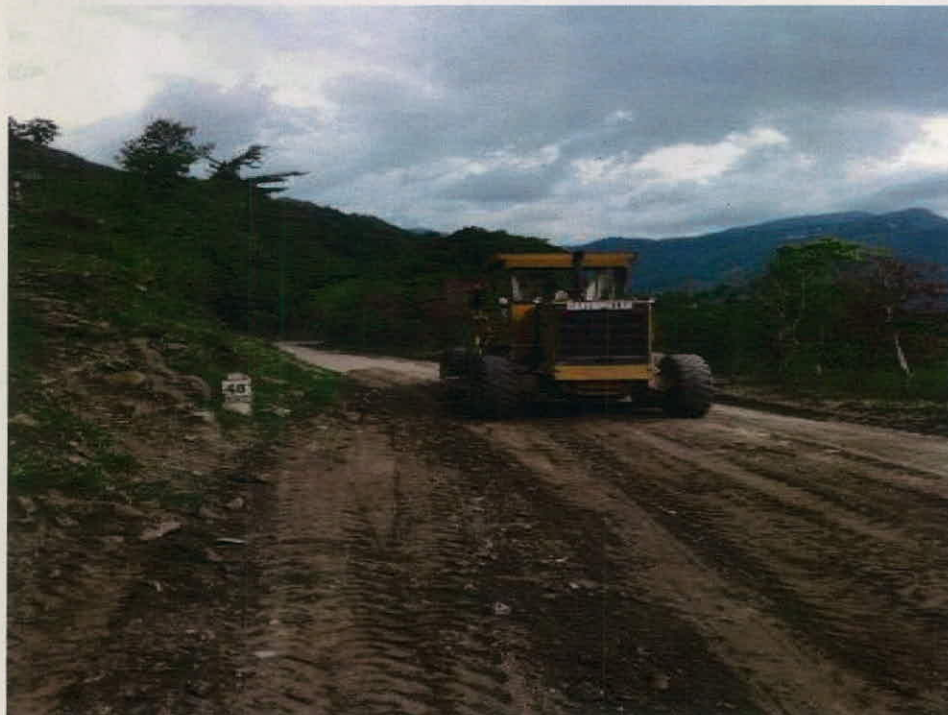
CONFORMACIÓN DE LA VÍA PR 48+000
