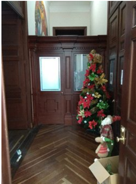
Instalación de división con puerta en Secretaria General
